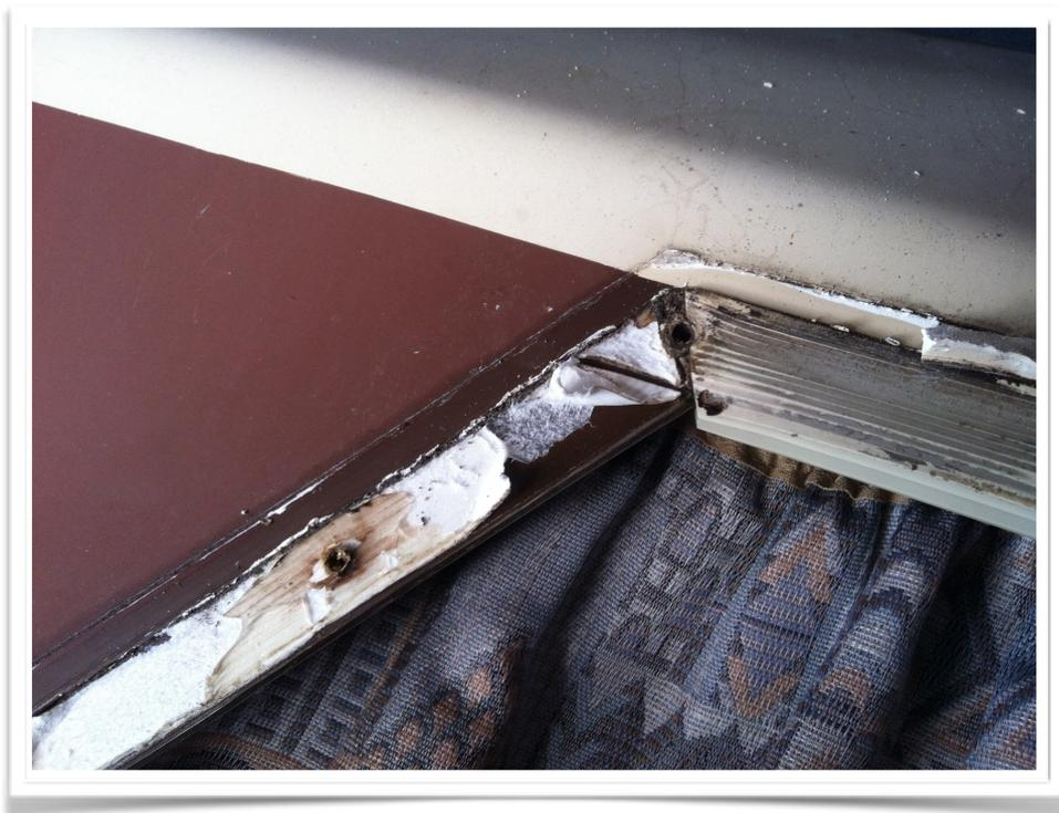
Hier wurde tatsächlich Spiegelklebeband verwendet um die Dichtung aufzukleben. - Das werde ich ganz anders lösen. -
