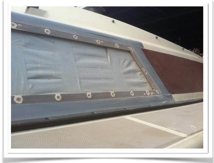
Zuerst habe ich mal alles mit Panzerband abgeklebt was ich nicht schmirgeln wollte. Dort wo die alten Schrauben im GFK saßen haben sich ziemliche Krater aufgetan. Diese habe ich mit einem Schmirgelklotz ziemlich plan geschliffen und den Rest gut angeschliffen.
